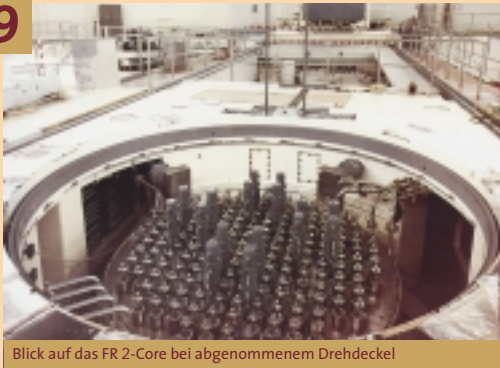
Blick auf das FR 2-Core bei abgenommenem Drehdeckel
